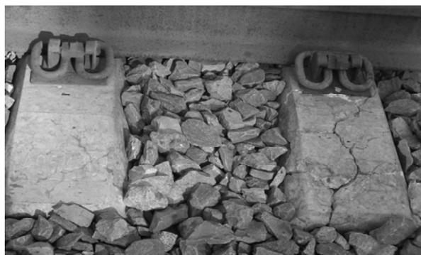
Рисунок 3. Третья стадия разрушения шпал
