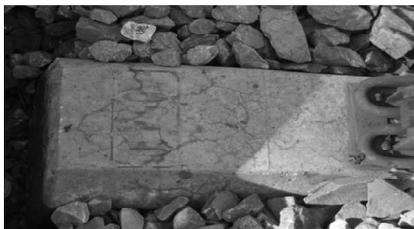
Рис. 1. Первая стадия разрушения шпал
